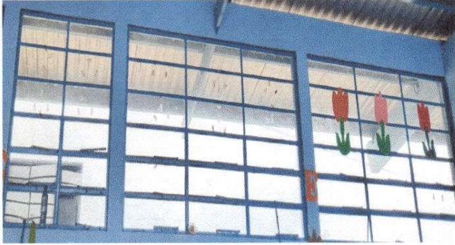
Foto 1: Sustitución de vidrios
