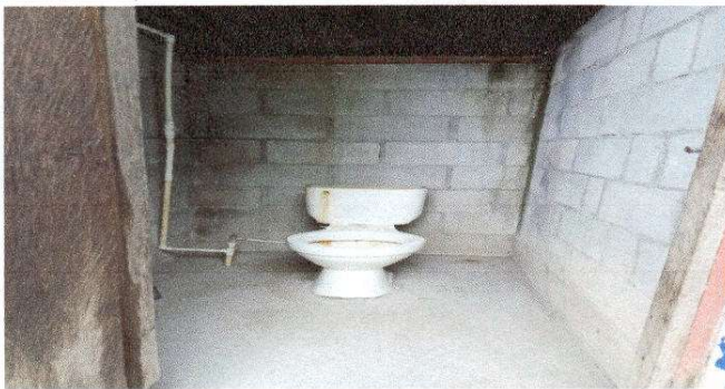
Foto 3: Sustitución Inodoro + Sustitución de accesorios inodoro
